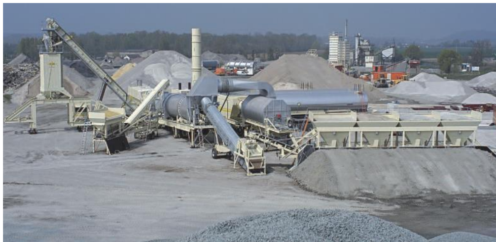
Illustration n° 7 : Vue d'une centrale d'enrobage de type TSM
